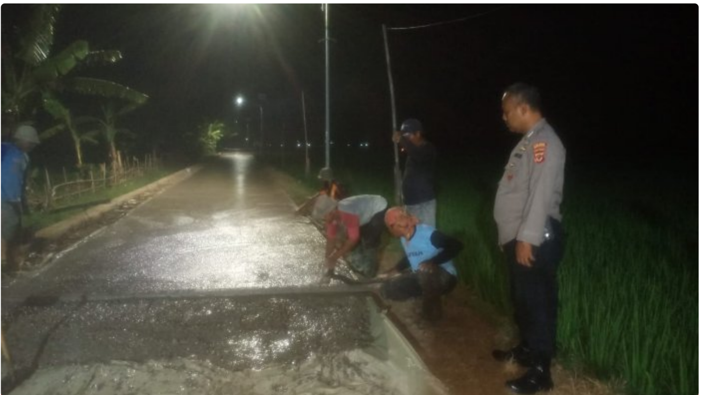
Bhabinkamtibmas Polsek Sliyeg Monitoring Pembangunan Pengecoran Jalan Desa
